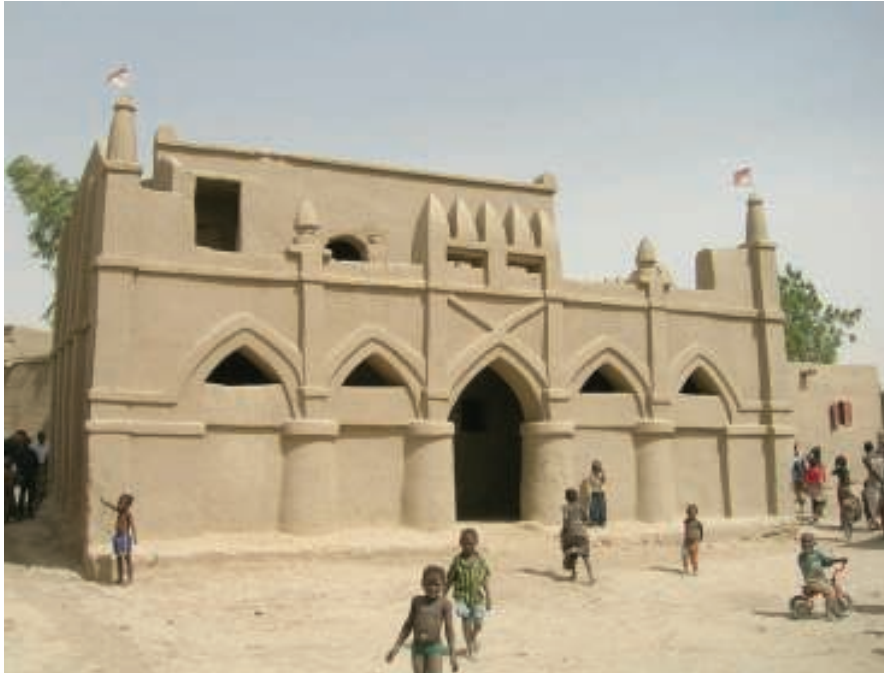
Foto 2 Saho Bayon Kube in Kouakourou. Naast Jamonati (foto 1) vormt deze saho het mooiste jongenshuis van het dorp. Toch vertoont het – met name doordat, vanwege het gebrek aan middelen, de tweede etage nooit is afgebouwd en de façade niet is doorgetrokken – zeker niet de monumentaliteit van haar voorganger van ruim een halve eeuw geleden. 8 Zowel op de beneden- als op de bovenverdieping zijn er drie kamers.
